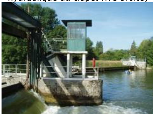
Pile de rive avec le local de (commande du pertuis, centrale hydraulique du clapet rive droite)
