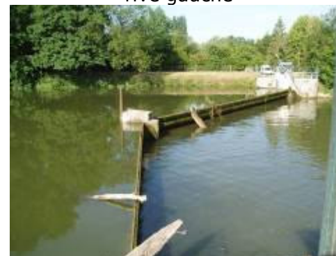
Le clapet rive droite, la pile centrale du déversoir et le clapet rive gauche
