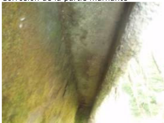
Corrosion de la partie marnante
