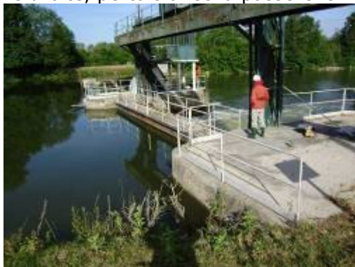
Pile de rive avec le local de (commande du pertuis, centrale hydraulique du clapet rive droite)
