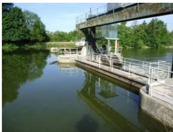
Plot béton d'appui de la passerelle
