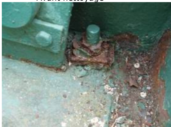
Ancrages corrodés Avant nettoyage
